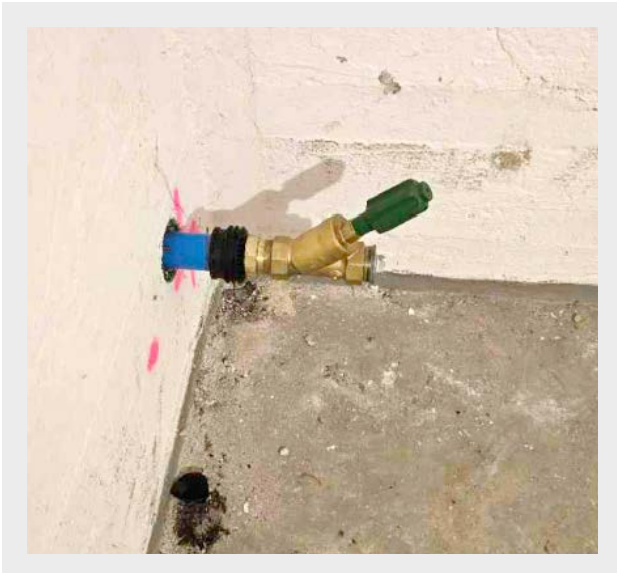
Hauseinführungskombination für Festpunkteinbau
